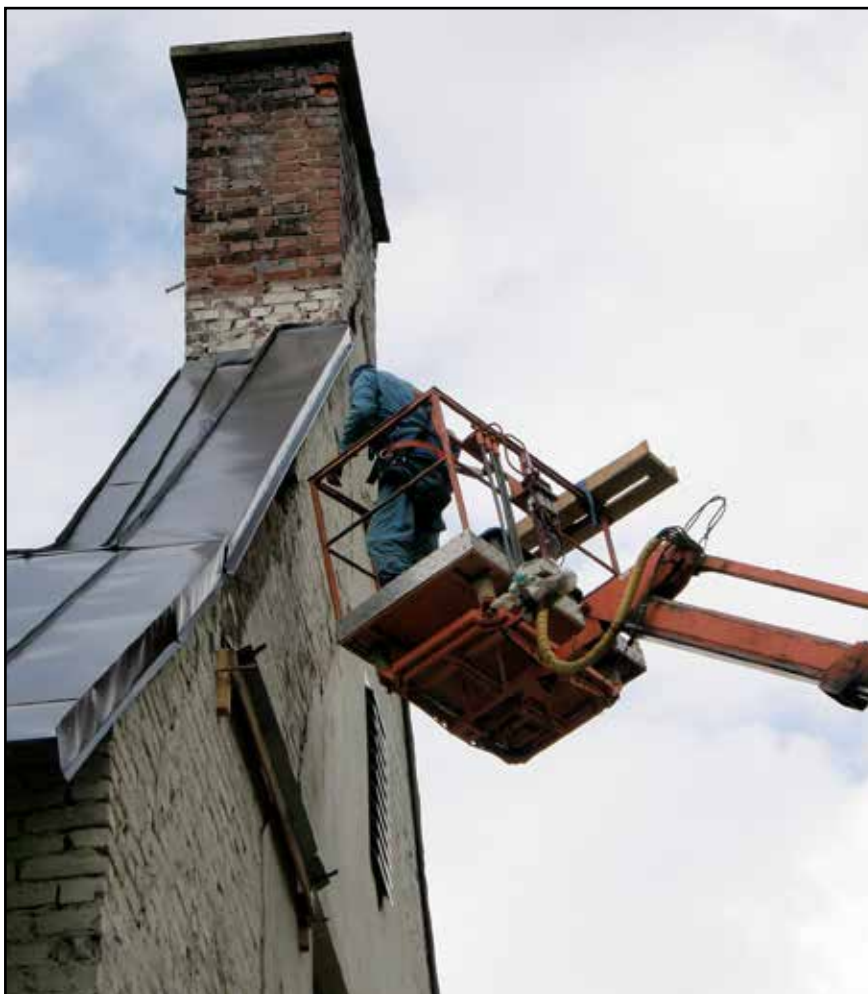
Toisen lappeen muurauksen korjaus.
