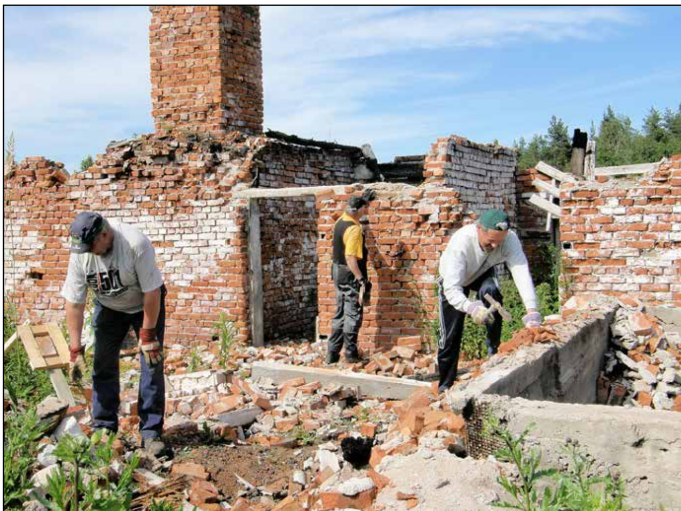
Martti, Ossi ja Pertti valitsemassa ja puhdistamassa tiiliä.
